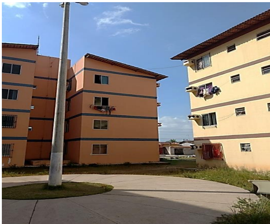
Foto 34 - Residencial Uirapuru: Blocos da quadra 26, bairro do Icuí
