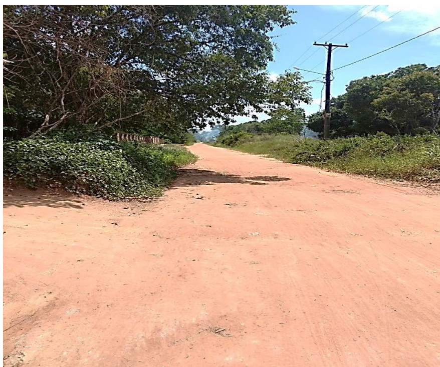
Foto 22 - Trecho da Estrada Santana do Aurá sem asfalto
