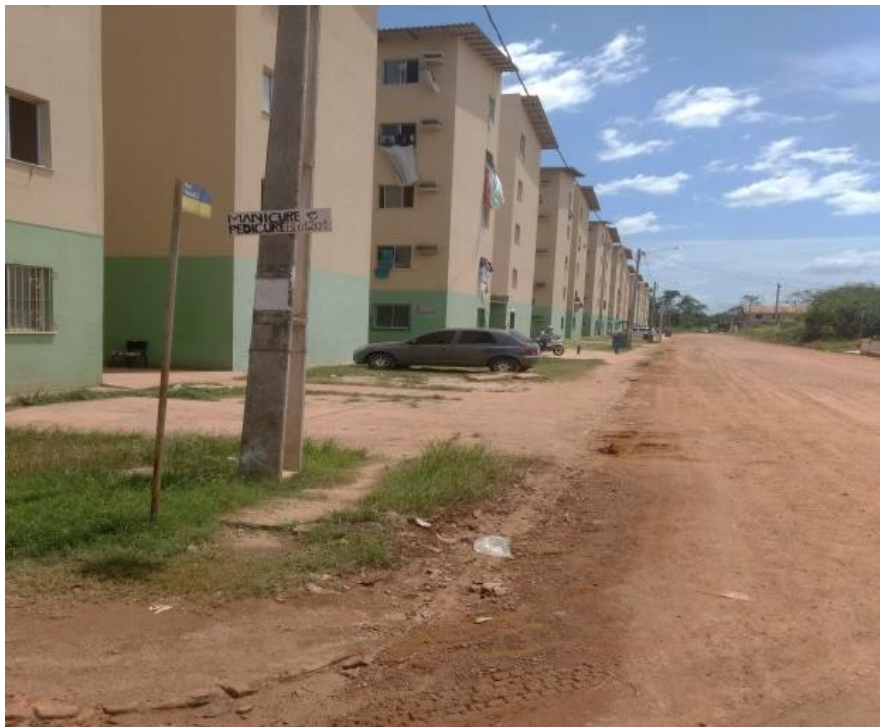
Foto 21 - Residencial Torres do Aurá, bairro Águas Brancas
