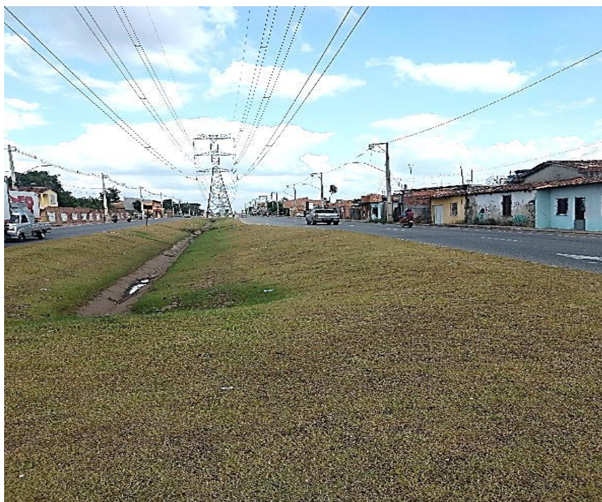
Foto 37 - Trecho da Avenida Independência, bairro Geraldo Palmeira
