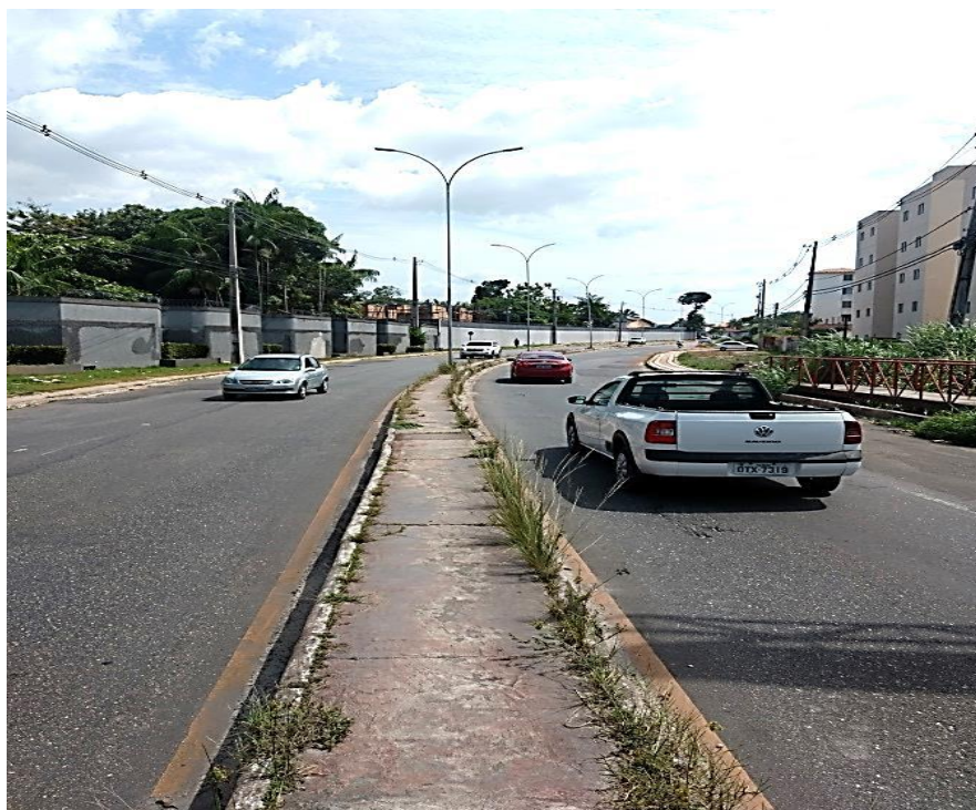
Foto 5 - Panorama da Avenida Hélio Gueiros. Ao fundo, o residencial Ilha do Marajó (faixa 2) em construção (à direita)
