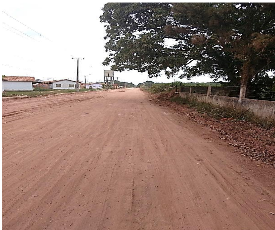
Foto 29 - Trechos da Estrada do Aurá: Trecho da Estrada do Aurá sem asfalto. Ao fundo, casas do Residencial Ananin, bairro Júlia Seffer
