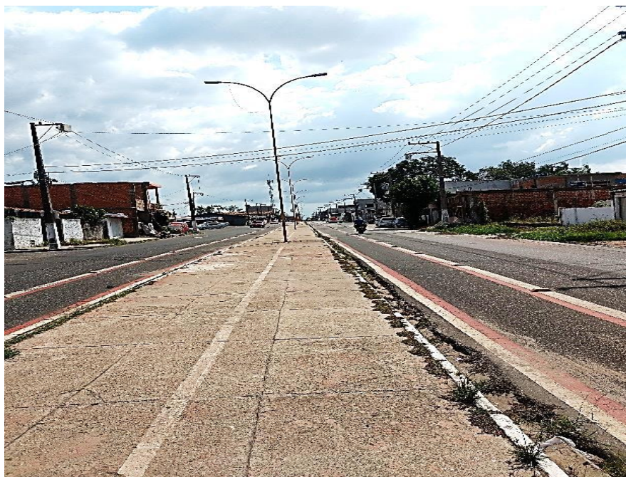
Foto 31 - Trecho final da Rua Santa Fé, próximo ao Residencial Uirapuru, bairro do Icuí
